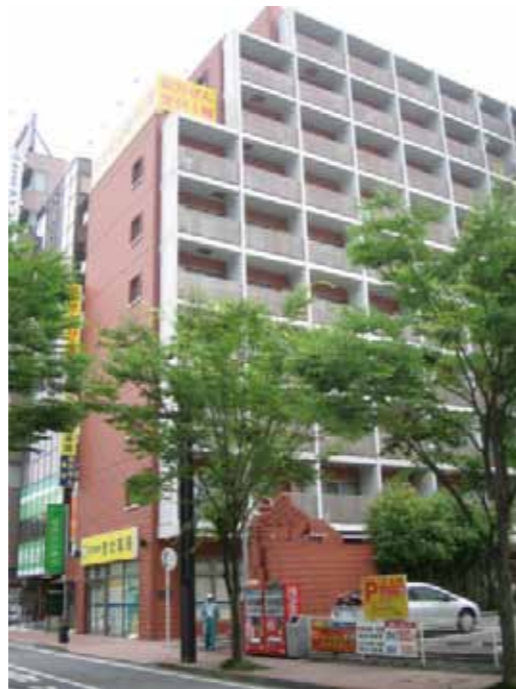
パークシティ新横浜(10階建)外観
